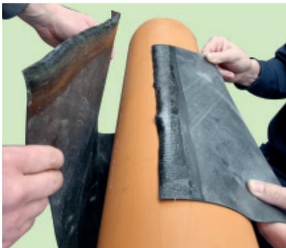
Une fois que la colle sur les bandes de collage a suffisamment séché, le joint d'extrémité AKO est enroulé autour du tube porteur
