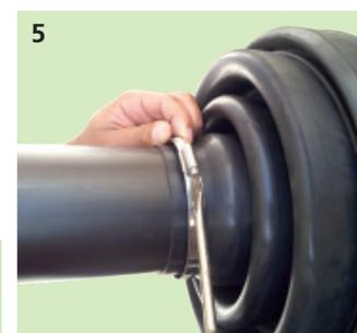
6. Pour conclure, fixez le joint AWM au tuyau porteur et au tuyau de tubage à l'aide de sangles en acier.
