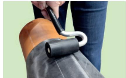
Aligner les deux bandes de collage l'une sur l'autre et les presser fermement l'une contre l'autre.
