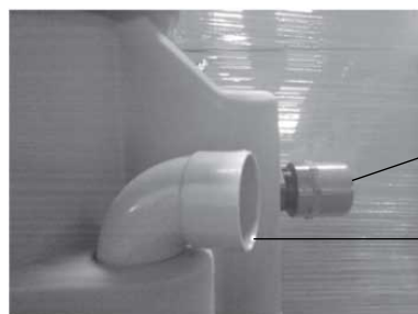
Raccord pour la conduite de refoulement. Manchon du chemin de câbles.
