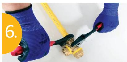
Ensuite, serrez l'écrou à l'aide d'une deuxième clé. Appliquer la couple de serrage comme indique dans le tableau 4
