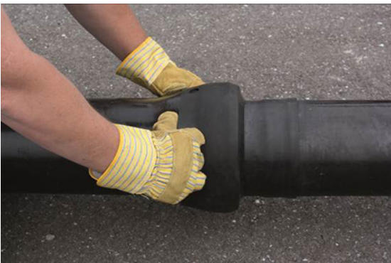
5- Rabattre la manchette sur l'emboîture pour protéger la jonction
