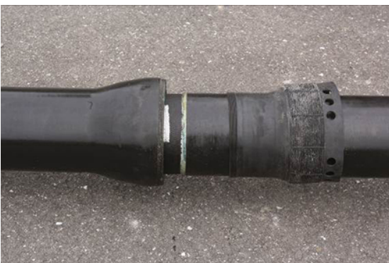
5- Rabattre la manchette sur l'emboîture pour protéger la jonction
