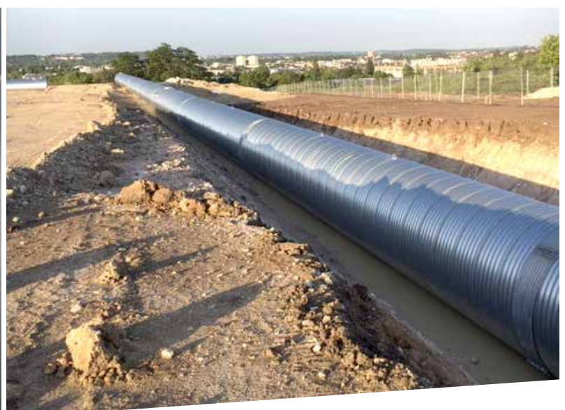
Colliers assemblés et serrés : les ondulations collier / tuyau se marient
