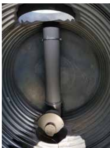
Vortex et surverse intégrée
