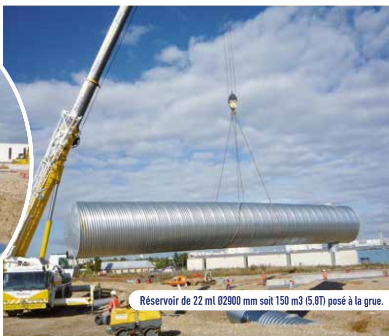
2 Réservoirs de 22 ml Ø2900 mm posés en parallèle.
