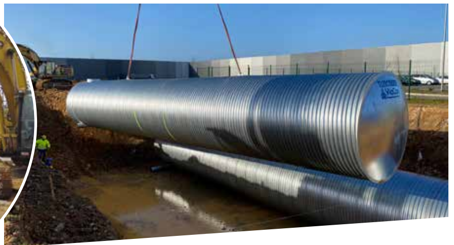
Les sangles sont positionnées en berceau sous le réservoir.
