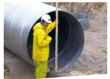
Pose classique : laser et mire
