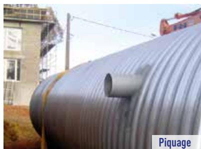
Percements pour drainage
