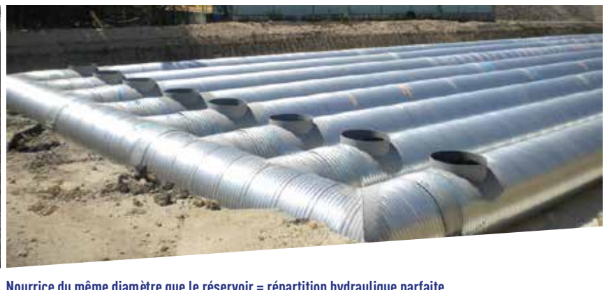
Nourrice du même diamètre que le réservoir = répartition hydraulique parfaite
