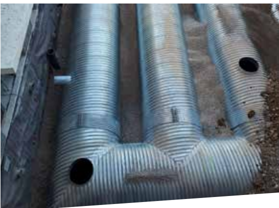
Nourrice du même diamètre que le réservoir = répartition hydraulique parfaite
