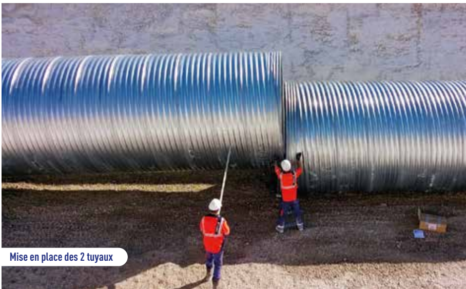
Utilisation d'un gabarit pour positionner le 2 e tuyau
