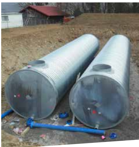
Réservoirs posés en parallèle
