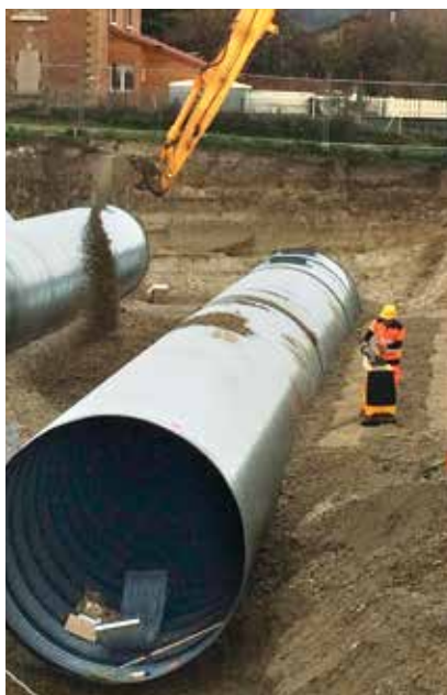
Compactage par couches symétriques de 30 cm
