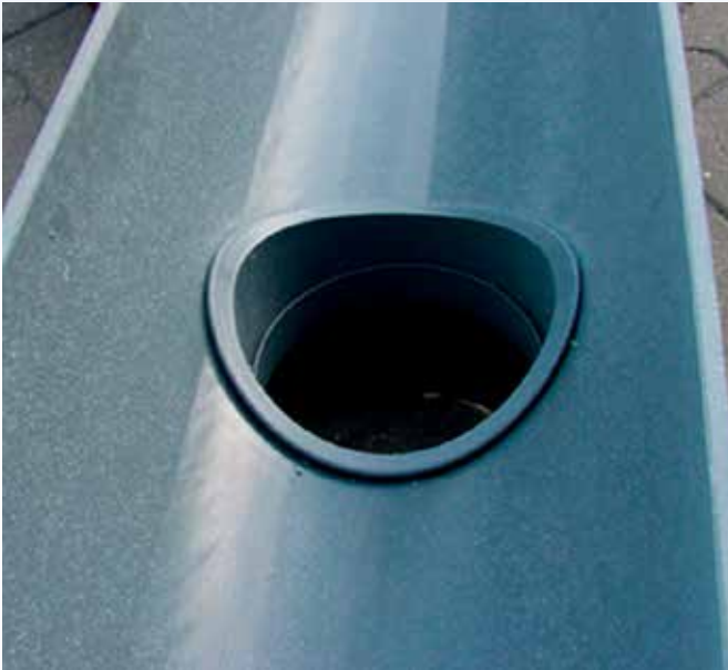
Vue intérieure après hydrocurage
